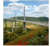
le Viaduc du Millau OCCITANIE
